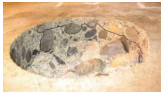
写真-5 コア抜き断面
