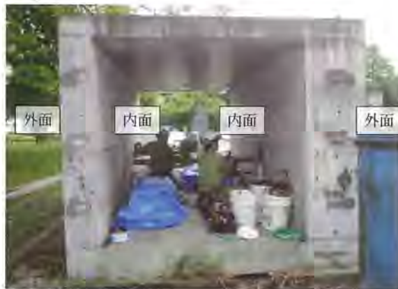
図9 ボックス供試体の外観状況。
