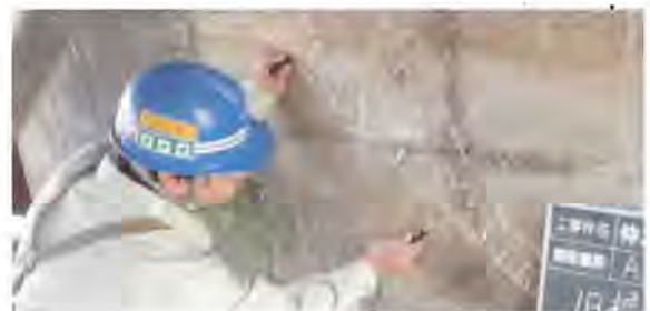
図3 弾性波伝搬速度の測定状況
