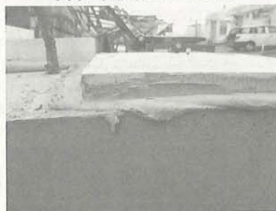
写真2 PCM板と母材コンクリートの密着状況
