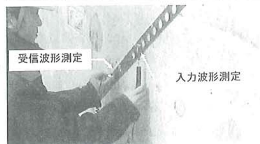
図-7 弾性波速度の測定状況
