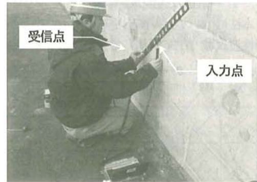
図4 構造物での速度測定状況
