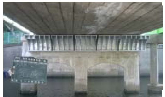
写真1 ブラケット設置状況
