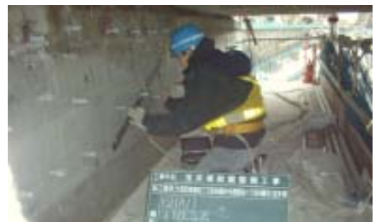
写真2 弾性波速度測定状況
