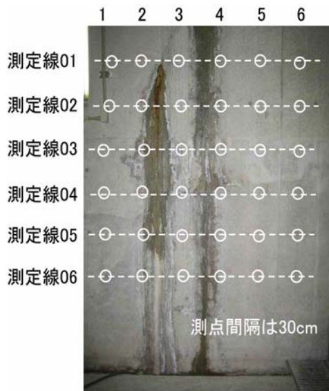
図 1 RC 水槽壁厚 1m の測定
