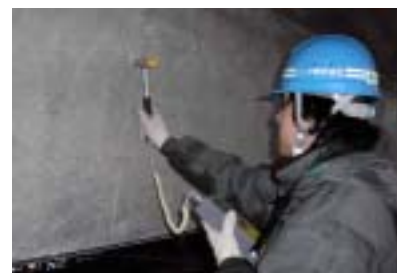
写真3 実構造物での機械インピーダンス測定
