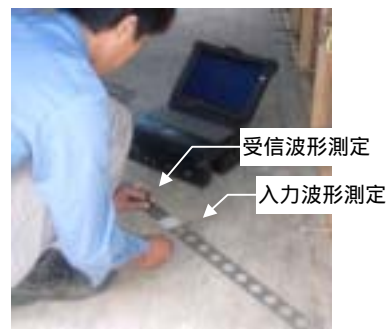
写真2 弾性波速度測定状況
