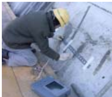
写真2 構造物B測定状況
