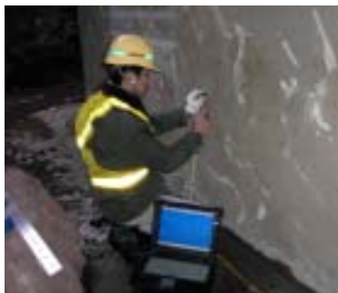
写真1 構造物A測定状況
