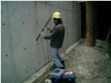
写真 1 構造物 E 測定状況
