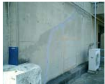
写真3 構造物D測定位置状況
