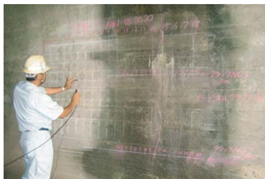
写真-1 トンネルの測定状況
